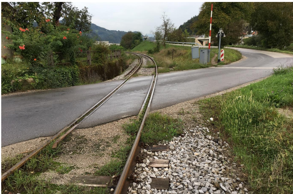
Slika 2: Pogled na NPr 0,7 Sevnica 1 v smeri stacionaže proge št. 81 oz. v smeri proti državni cesti R2-424/1166
